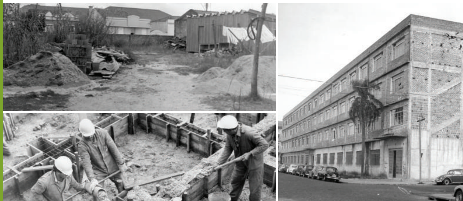
Fotos abaixo, esquerda para direita: Espaço sendo desocupado para a construção; Operários trabalhando; Prédio do Campus I já erguido.
