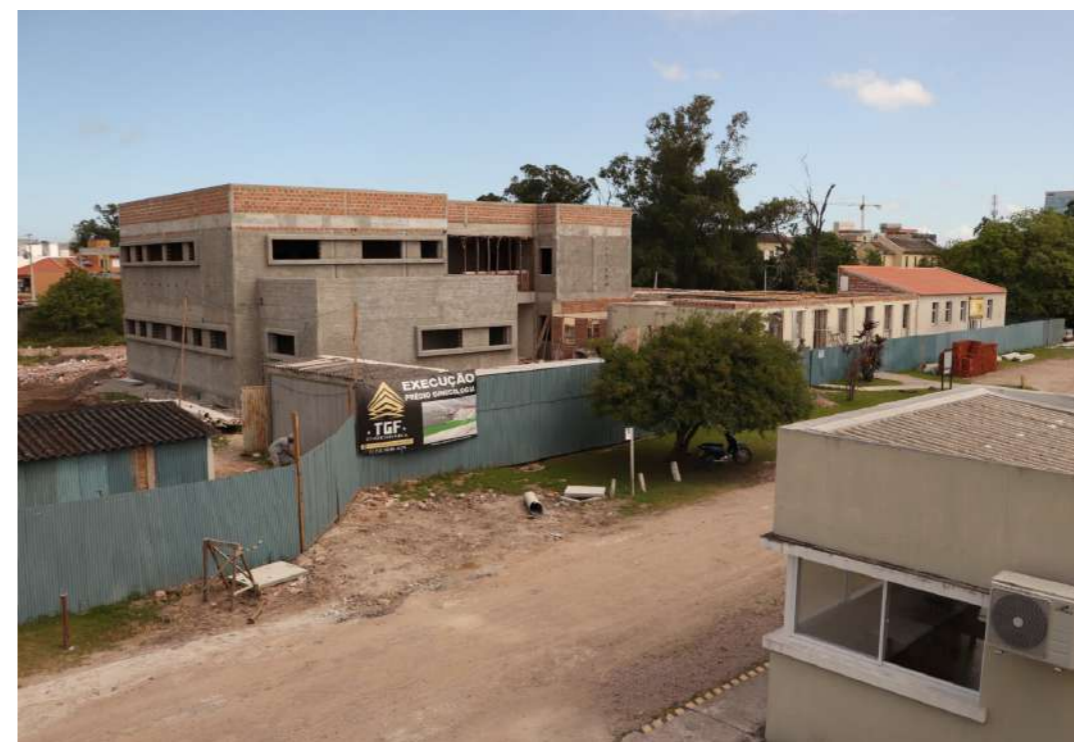
Obras dos novos ambulatórios de Ginecologia e Obstetrícia, Pediatria, Oftalmologia e Otorrinolaringologia
